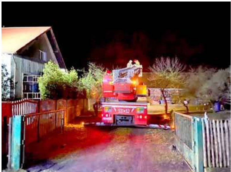
W minioną sobotę strażacy zostali zadysponowani do uszkodzonego dachu w miejscowości Niedźwiedź. Foto. OSP. Kobylanka
