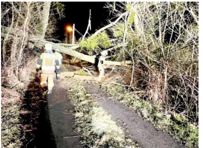
W miejscowości Boguszyce strażacy usuwali drzewo, które spadło na drogę prowadzącą do posesji oraz częściowo zaczepione było o linie energetyczne. Foto. OSP. Dolice
