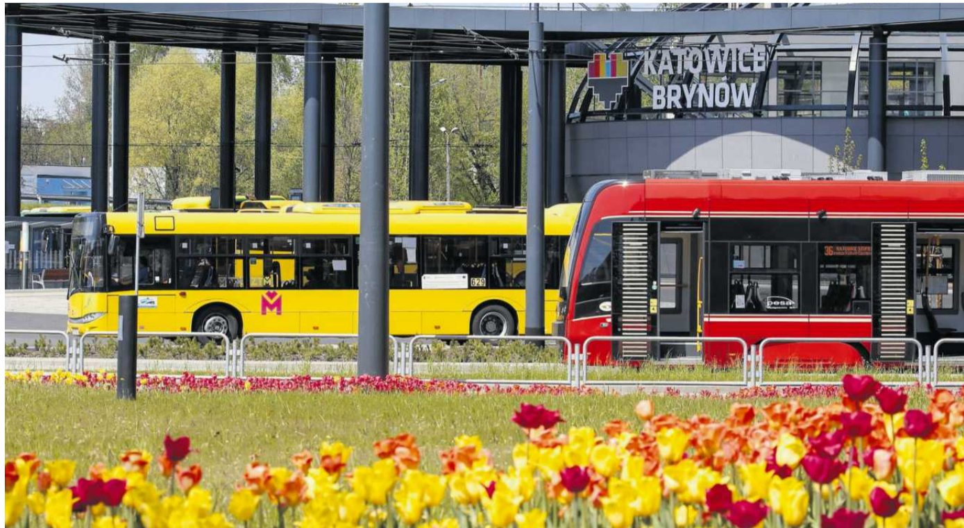
• Centrum przesiadkowe w Brynowie FOT. TOMASZ KAWKA
