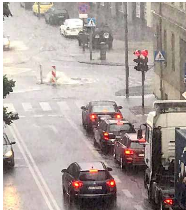
Studzienka na ulicy Konopnickiej nie nadążała z odbieraniem wody. Foto. Stoją!Stargard
