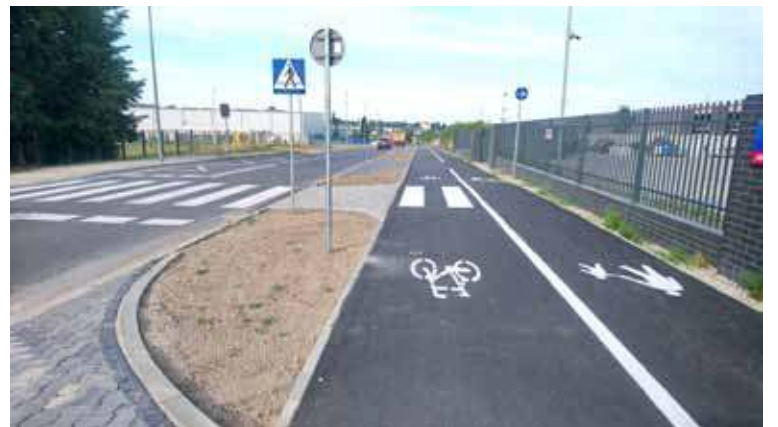
Zakończyła się budowa ścieżki rowerowej na ulicy Nasiennej. Piesi i rowerzyści mają do dyspozycji 600 metrów komfortowej nawierzchni
