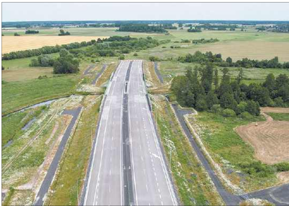
Znamy wykonawcę odcinka A2 z Białej Podlaskiej do węzła w rejonie Kijowca
