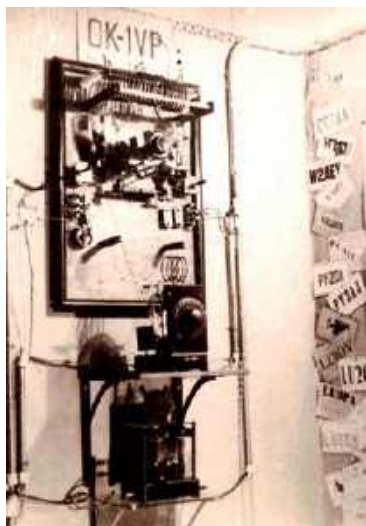
Zrobiony na drewnianym blacie nadajnik zawieszony na ścianie
