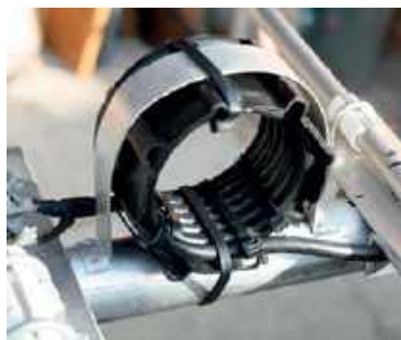
Rys. 1. Różne konstrukcje dławików antenowych
