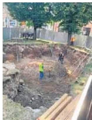
Prace przy rewitalizacji skweru w Nowym Sączu
