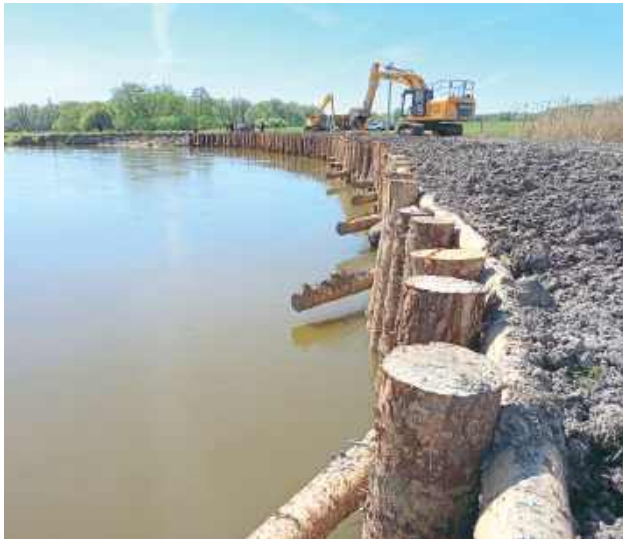
Zakończenie prac obok Jabłecznej
