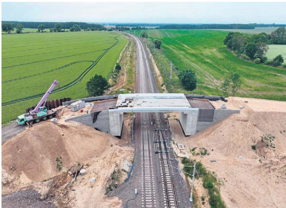
Trwa intensywna przebudowa pomorskich magistrali
