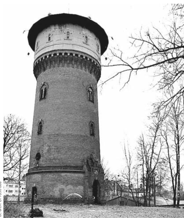
Wieża ciśnień w Ostródzie
