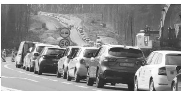
Wylot z Olsztyna zostanie przebudowany
