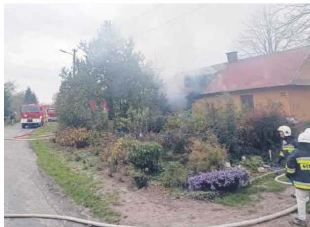
Do pożaru doszło 24 października 2022.
