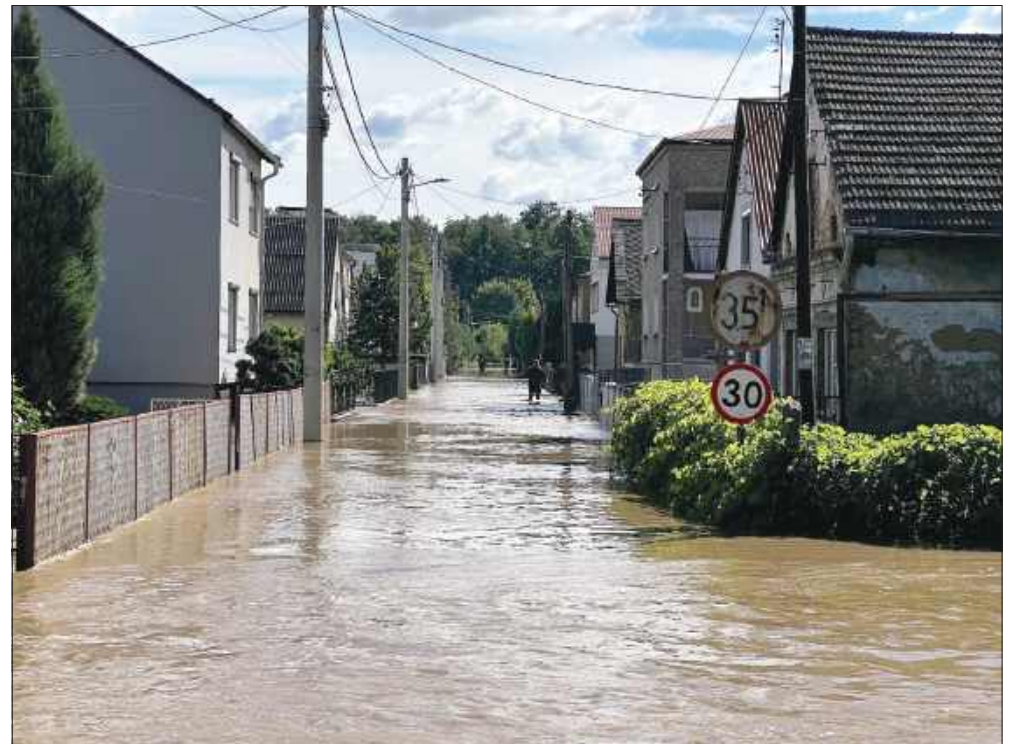
■ Taki widok był w Krzanowicach po powodzi we wrześniu 2024 roku. Zapowiadane od kilku lat prace związane z przekopem mają poprawić odpływ wód z potoku Biała Woda, a w konsekwencji zwiększyć bezpieczeństwo przeciwpowodziowe. FOT. OQL
