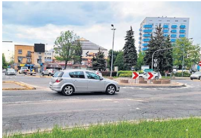
Przez ponad rok w tym miejscu Tarnowa trwać ma budowa ronda oraz przejścia podziemnego
