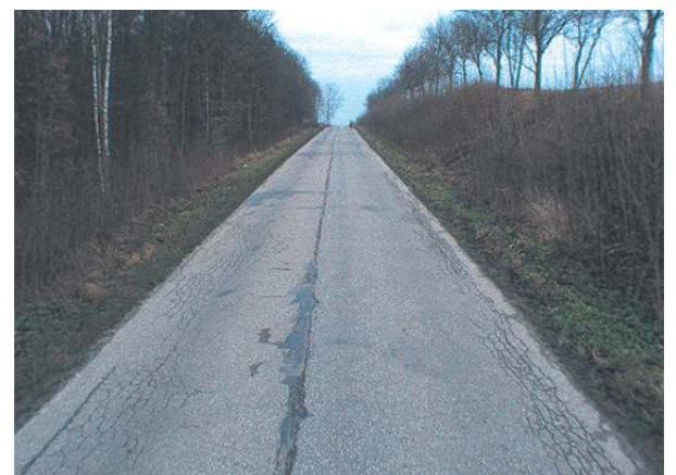
Droga Mała Klonia – Gostycyn przed odbudową.
