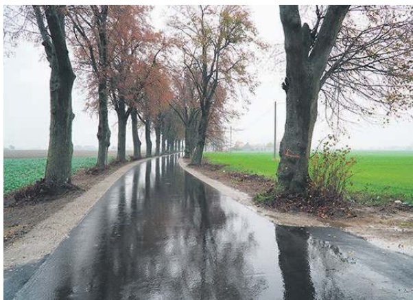
Droga Mała Klonia – Wielka Klonia po odbudowie.
