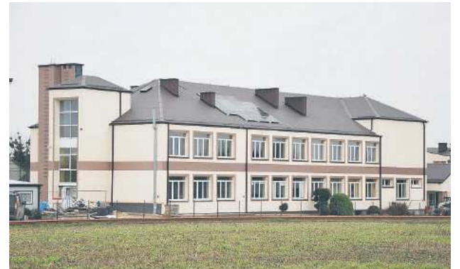
Termomodernizacja i OZE w SP w Krupem (2019)
