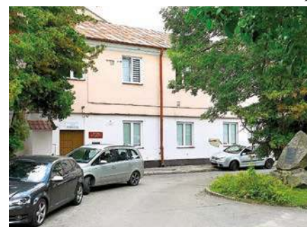
Poklasztorny budynek zostanie wyremontowany
