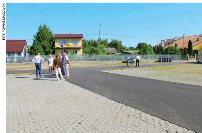
Obiekt zyskał m.in. nowe nawierzchnie
