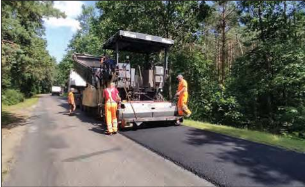
➤ Prace już trwają na drodze z Maciejowic do Pogorzała
