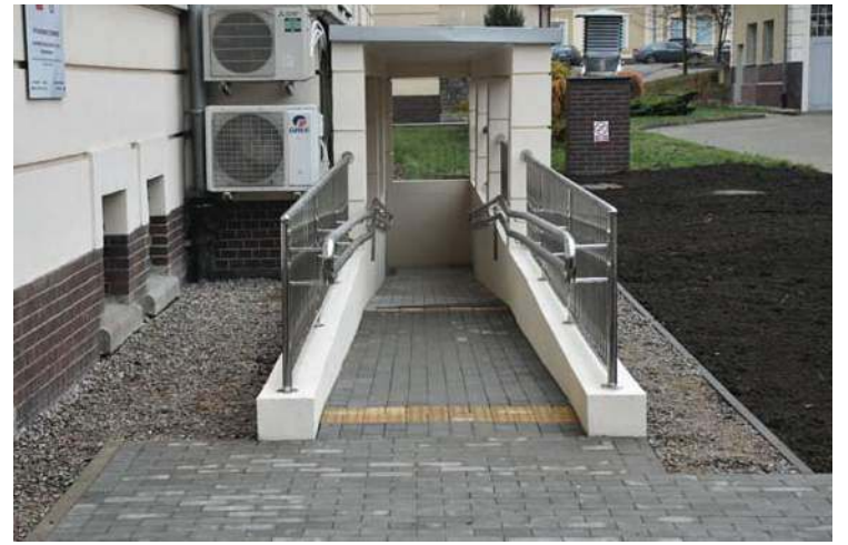
Nowo wybudowany wjazd do budynku Starostwa Powiatowego w Ostródzie
