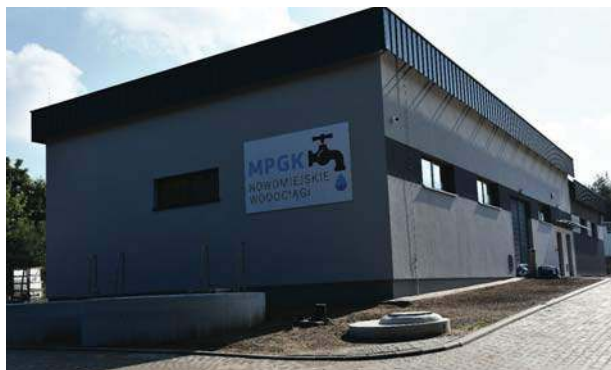
Nowa stacja uzdatniania wody
