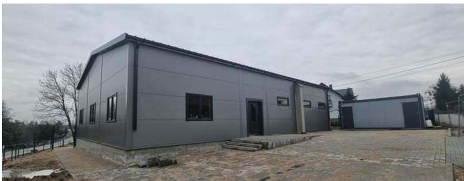
Remiza w Wilkowie w trakcie budowy
