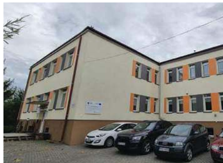
Szkoła Podstawowa w Biedaszkach po termomodernizacji
