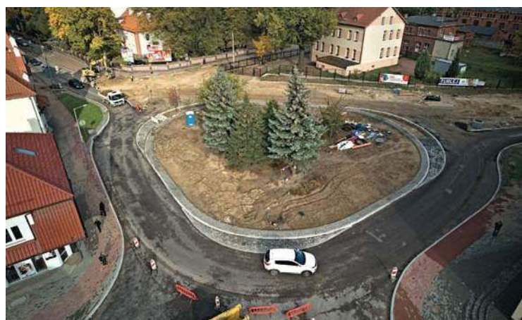
Przebudowa na rondo skrzyżowania ulic Grunwaldzka – Drwęcka – Kopernika – I Dywizji w Ostródzie (fot. Wiesław Ruczyński)
