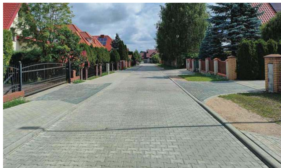
Jedna z 29 wyremontowanych ulic w Szczytnie
