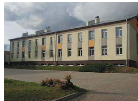
Szkoła Podstawowa w Nakomiadach po termomodernizacji
