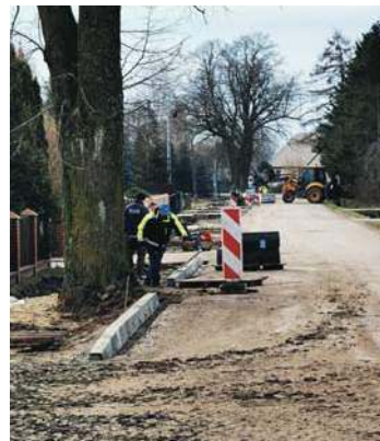
Przebudowa chodnika Wielki Łęck
