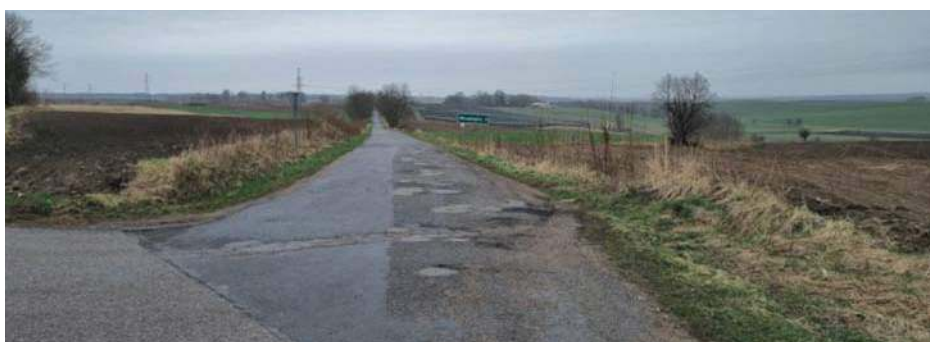
Droga w miejscowości Windykajmy przed przebudową
