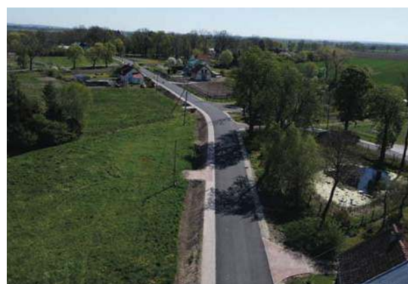
Remont drogi w Fiszwie
