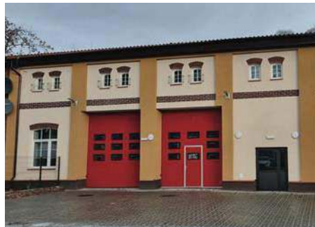
Remiza w Karolewie po przebudowie
