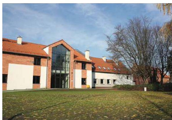
Remont budynków LSP
