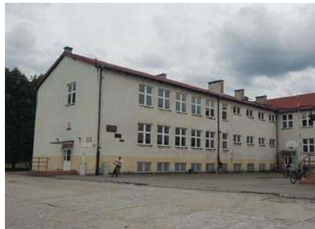
Szkoła Podstawowa w Wilkowie przed termomodernizacją
