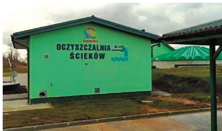
OCZYSZCZALNIA ŚCIEKÓW W KALINOWIE
