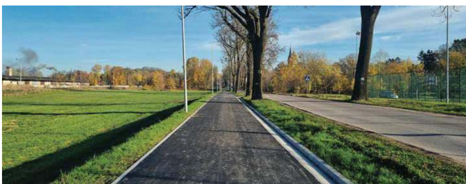
Ścieżka rowerowa I etap Karolewo – Czerniki (Jez. Mój)
