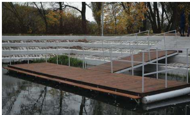
Przystań kajakowa po modernizacji
