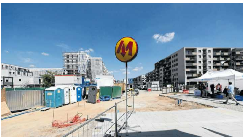
• Na stacji Chrzanów ułożono już posadzki z lastryka. Pierwsze elementy ścian zatorowych na poziomie -2 są zaś wykonane z ażurowej blachy perforowanej. Podobne widać też nad peronem. FOT. SŁAWOMIR KAMIŃSKI / AGENCJA WYBORCZA.PL
