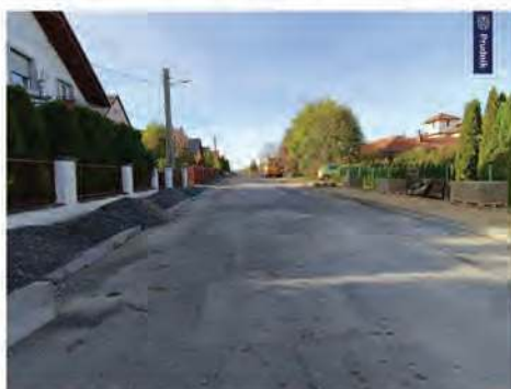
Ulica Wybickiego w trakcie remontu.
