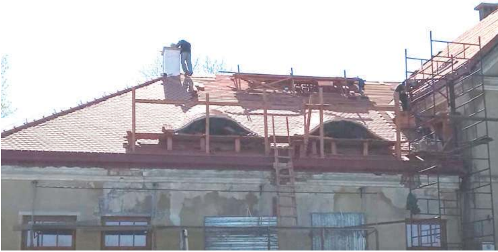
Trzeba m.in. wymienić pokrycie dachowe z eternitu na dachówkę. Te prace są zaawansowane
