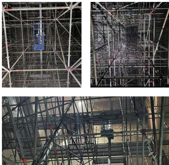
Fot. 1. Dźwig GEDA 300 Z Boiler Hoist wewnątrz kotła w elektrowni
