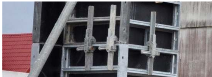
Fot. 3. Zamek klinowy z wydłużonym korpusem, łączący i prostujący płyty nadstawki
