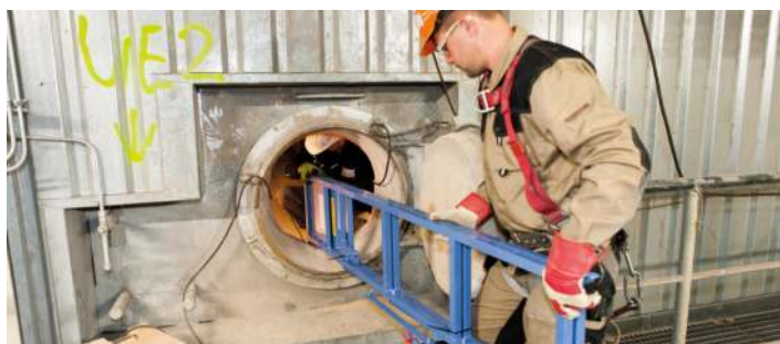
Fot. 3. Transport elementów dźwigu GEDA 300 Z Boiler Hoist przez właz do wnętrza kotła
