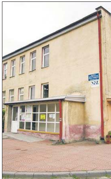
W ośrodku zdrowia w Pilźnie wyremontowane zostaną piwnice.
