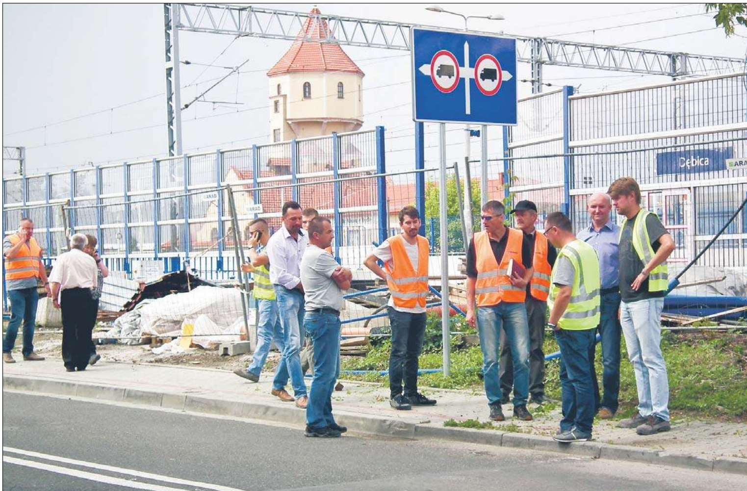
W samo południe w poniedziałek 21 sierpnia odbył się odbiór techniczny inwestycji u zbiegu ulic: Staszica, Konarskiego i Głowackiego.
