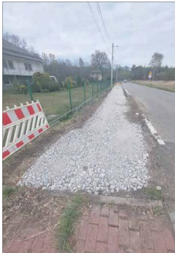
Chodnik jeszcze w trakcie prac
