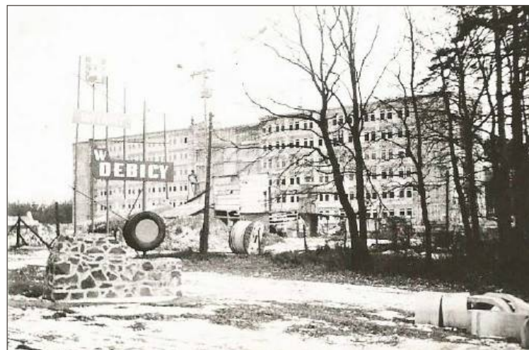
Rok 1974. Szpital w budowie.
