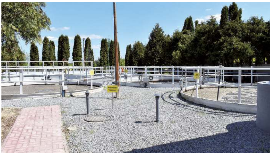
Przebudowa oczyszczalni ścieków wraz z rozbudową systemu wodociągowego o wartości 3 492 335 zł
