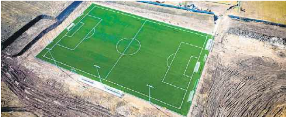
Budowa nowego boiska przy ul. J. Niemcewicza kosztowała prawie 5 800 000 zł
