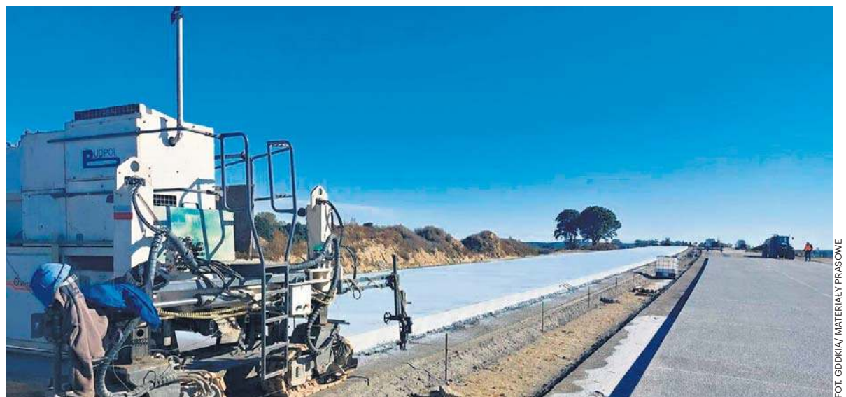
Budowa drogi S6 na odcinku Bobrowniki - Skórowo. Tutaj droga będzie mieć betonową nawierzchnię
