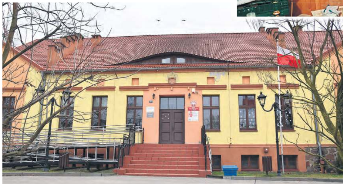
Tymczasowe lokale mieszkalne mają powstać od frontu zabytkowego dworku, na poddaszu. Fot. (aw)
