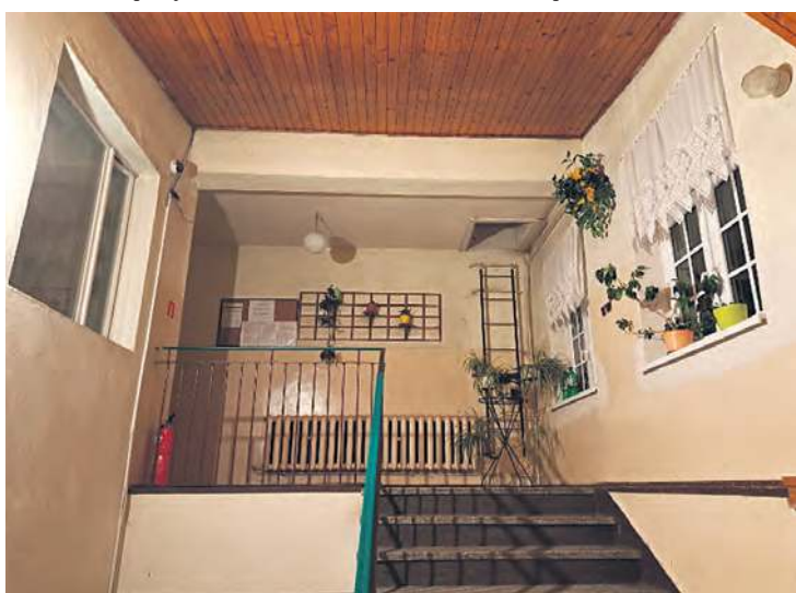
Zakres prac w pałacu obejmuje m.in. oddzielenie klatki schodowej od części mieszkalnej. Fot. z dokumentacji projektowej, nadesłane
