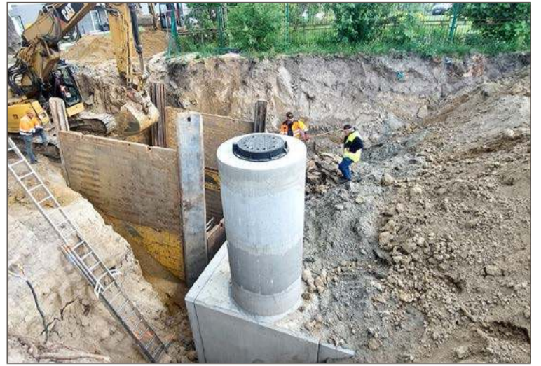
Budowa zbiornika retencyjnego przy ul. Akademickiej w Dębicy.
