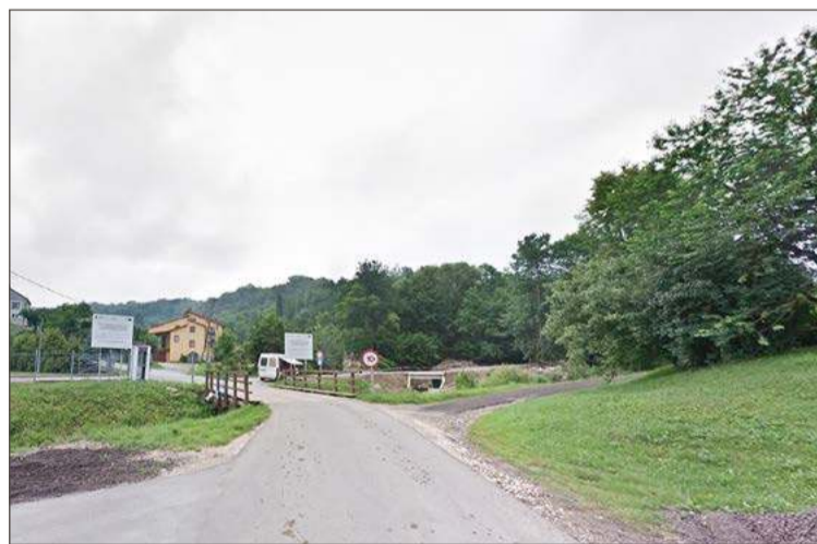
Przebudowana ma być również zatoka autobusowa.
