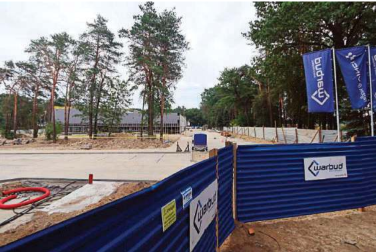
Budowa kompleksu „Park Avia” przekroczyła już półmetek
