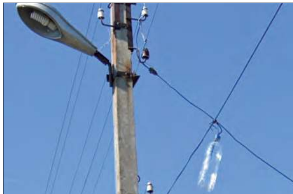
Butelkowa izolacja i domowa żarówka ledowa w ulicznej lampie. Na głębince trzeba sobie jakoś radzić.
