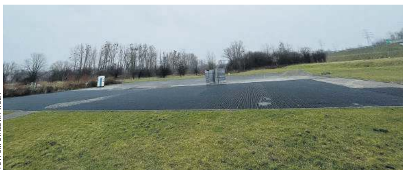
Trwa remont parkingu na błoniach
