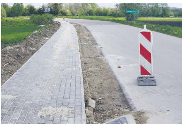
Modernizacja drogi w Kamieniu-Kolonii
