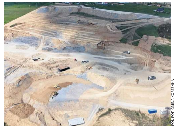
Plac budowy w Wojnarowej. Specjaliści przeprowadzą dodatkowe analizy geologiczne i geotechniczne
