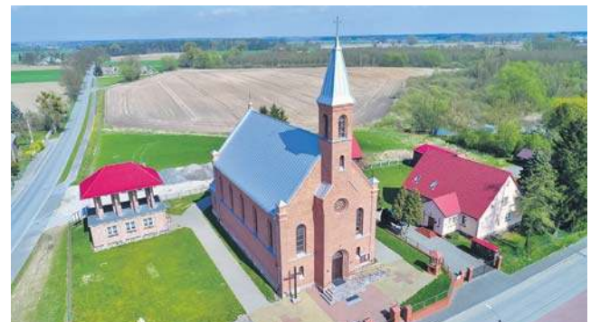
W kościele w Polskich Łąkach wymieniono pokrycie dachu
