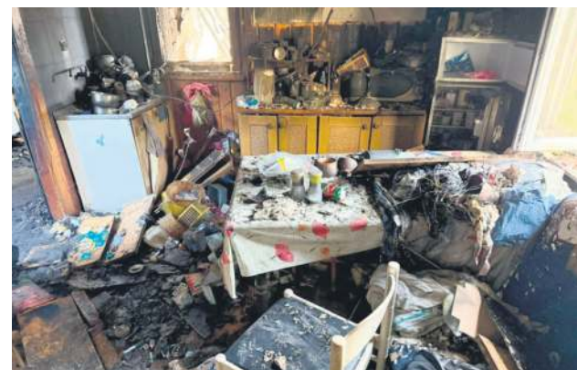
Budynek nie nadaje się do zamieszkania.
