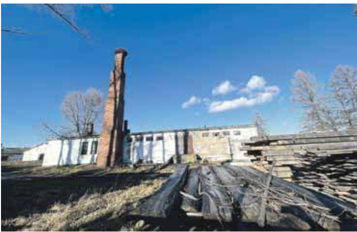
W tym miejscu ma powstać biogazownia.
