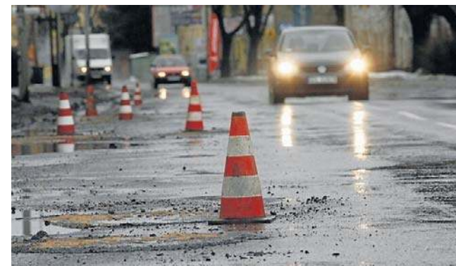
Jak tłumaczą legnicy drogowcy, częste przechodzenie temperatury przez 0 st. jest wielkim wrogiem nawierzchni
