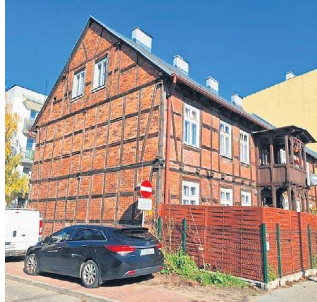
W budynku przy ulicy Lubickiej 45 spółka PGE Toruń tymczasowo uruchomiła kotłownię elektryczną
