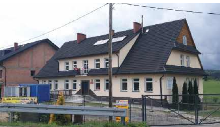
Základná škola spolu s novou športovou halou vo výstavbe
