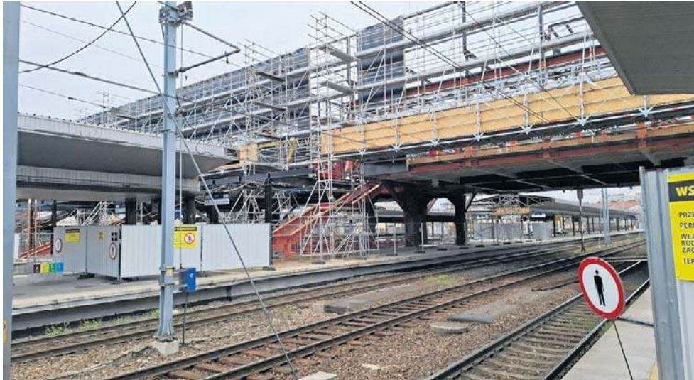
Na placu budowy widać już zarys przyszłego układu obiektu. Część wschodnia dworca z pawilonem, kasami i wieżą zegarową ma być gotowa w 2026 roku
