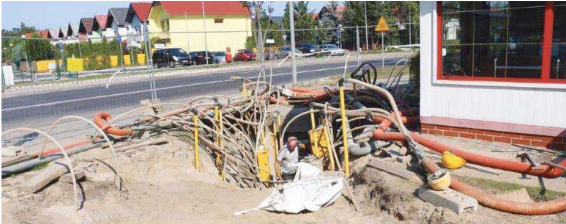
Prace nad tą inwestycją już się rozpoczęły (fot. Ewa Batko/UM)
