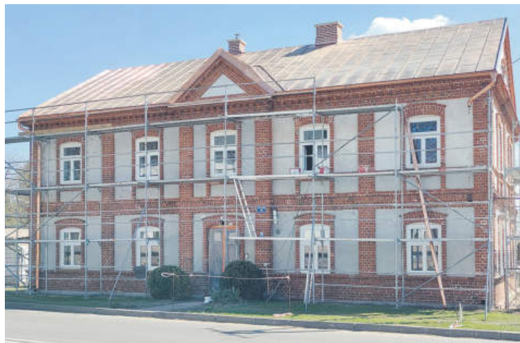
Wikariat w czasie remontu
