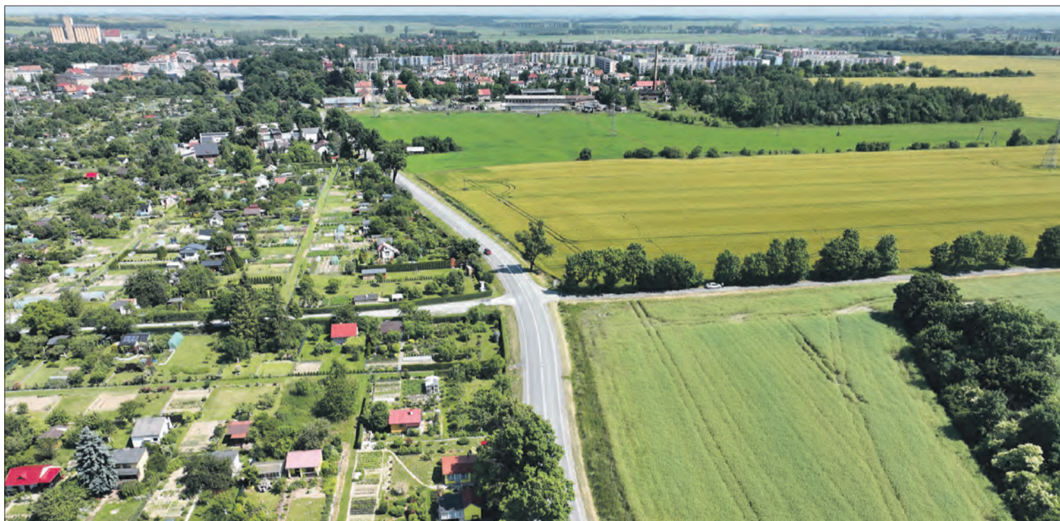
W tym miejscu znajduje się początek Prudnika od strony Trzebiny. Powstanie tu rondo.
