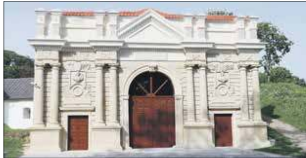
Zakończono prace konserwatorskie przy frontonie bramy wjazdowej na terenie parku Radziwiłłów w Białej Podlaskiej
