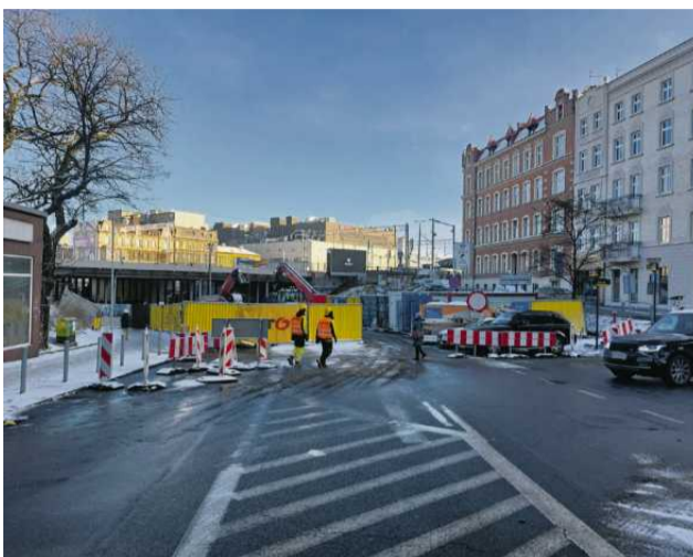
• Przebudowa wiaduktu nad ul. Mikołowską w Katowicach
