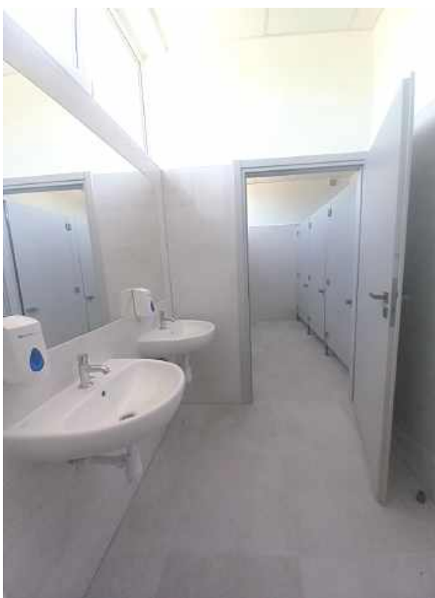
Remont przeszły między innymi łazienki szkolne
