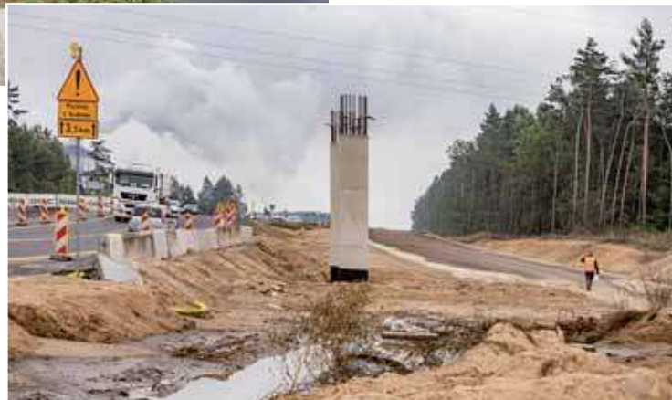
W Zigmuntowie pod Głinojeckiem, na wysokości cukrowni, z powodu przebiegu nowej trasy wycięto sporą część lasu
