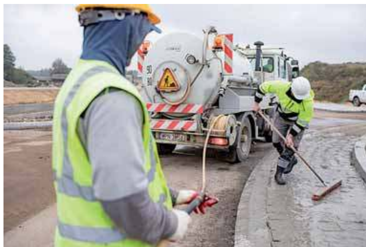
Budowa nowego węzła w Pieńkach
