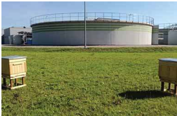
Ule stanęły przy urządzeniach oczyszczających wodę
