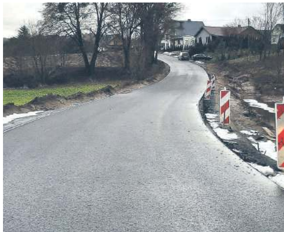
Wyremontowana droga w Drewnikach
